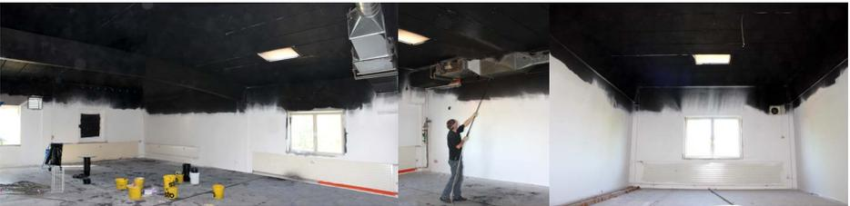
**Abschirmung Doppelhaushälfte (2648  $\mu\text{W}/\text{m}^2 \rightarrow 10,2 \mu\text{W}/\text{m}^2$ ), Deutschland**
