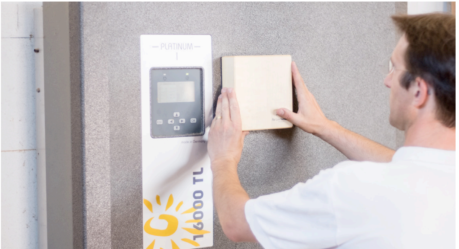
Montage eines Relux Ionisators am Wechselrichter einer Solaranlage.
